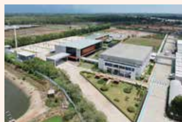
安全、品質、TPS等、生産の基礎となる知識や技能を研鑽する7つの「道場」を備えたTraining Building。
