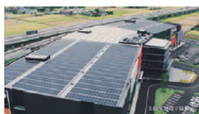
プラネット埼玉屋上の太陽光発電パネル
