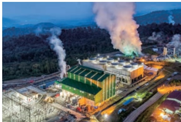
ムアララボ地熱発電所
