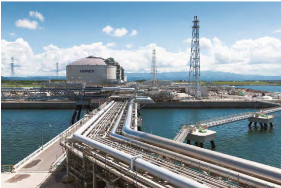
Naoetsu LNG Terminal
