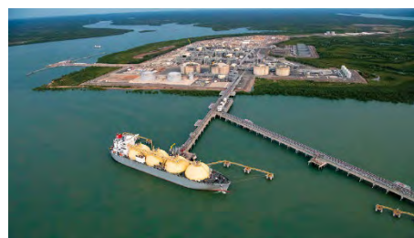
Darwin LNG Plant and LNG vessels
