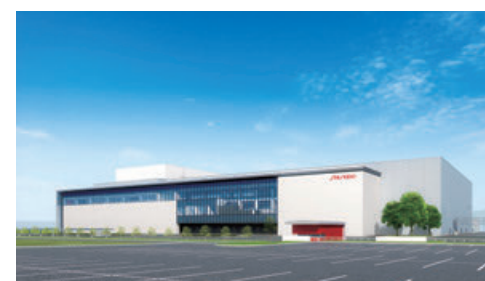
福岡久留米工場(2022年5月稼働予定)
