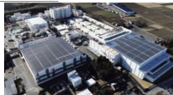
自家消費用太陽光発電を導入した 花王の栃木工場
