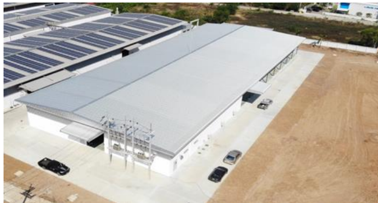
第4工場（新設） 右側は第5工場建設予定地予定
