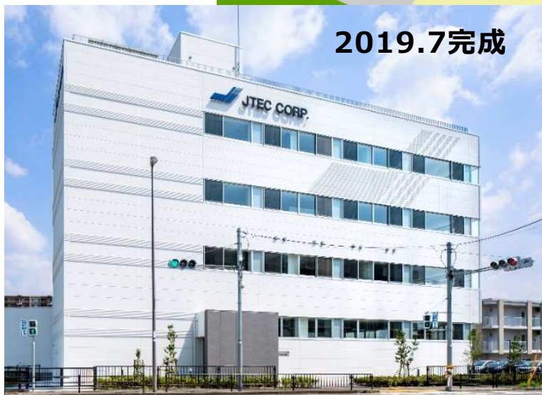
新本社・加工・計測棟：約5500m 2
