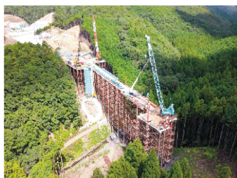
道路・橋梁工事
