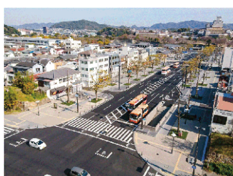
道路整備工事
