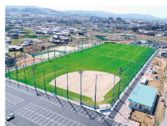
スポーツ・レジャー施設工事
