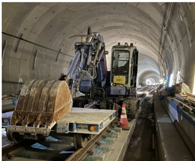
<レール上を走行できる工事車両>
