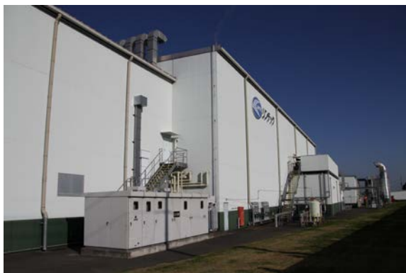
積層セラミックコンデンサ関連テープの既存生産工場(埼玉・熊谷工場)
