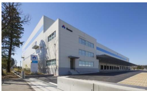
3 ロジスクエア日高 2015年3月竣工
