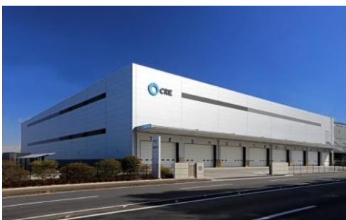
6 ロジスクエア久喜Ⅱ 2017年2月竣工
