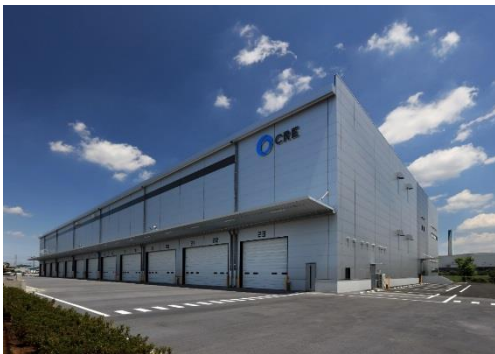
15 ロジスクエア川越Ⅱ 2019年6月竣工
