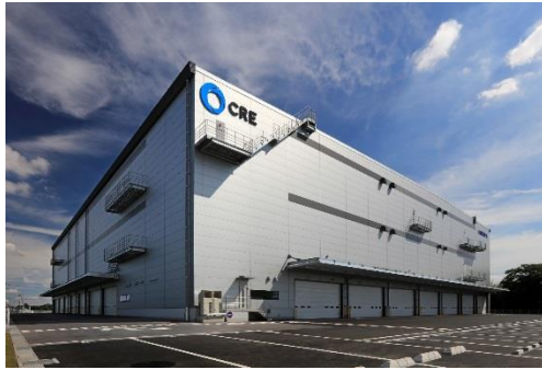
13 ロジスクエア春日部 2018年6月竣工
