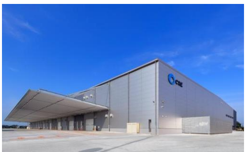
5 ロジスクエア羽生 2016年7月竣工
