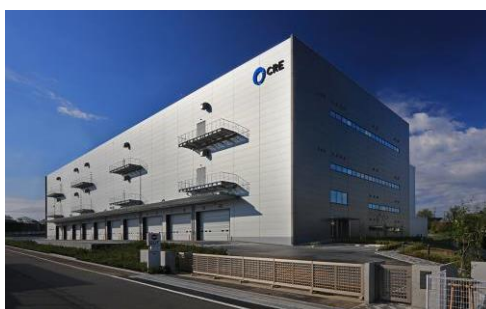
8 ロジスクエア新座 2017年4月竣工
