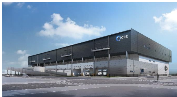
22 ロジスクエア白井 2022年12月竣工予定
