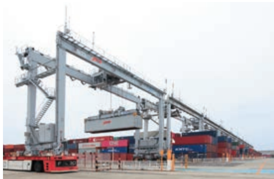
遠隔操作RTG
