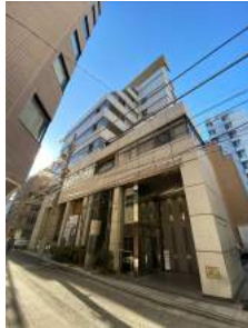
新橋フロンティアビル
