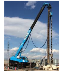
アポロン工法
