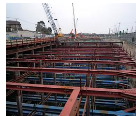
各種仮設解体工事
