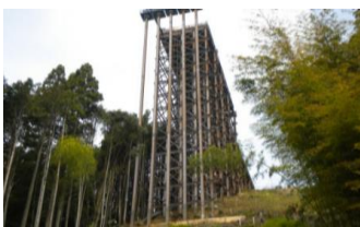
KOSMOSゴンドラ工法
