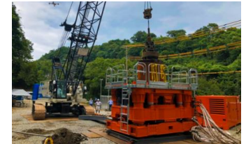
全周回転工法
