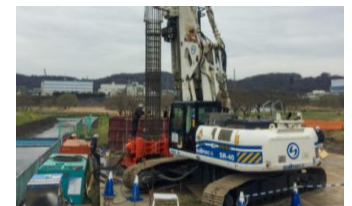
マルチドリル工法
