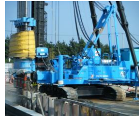
ソイルセメント柱列式連続壁工法
