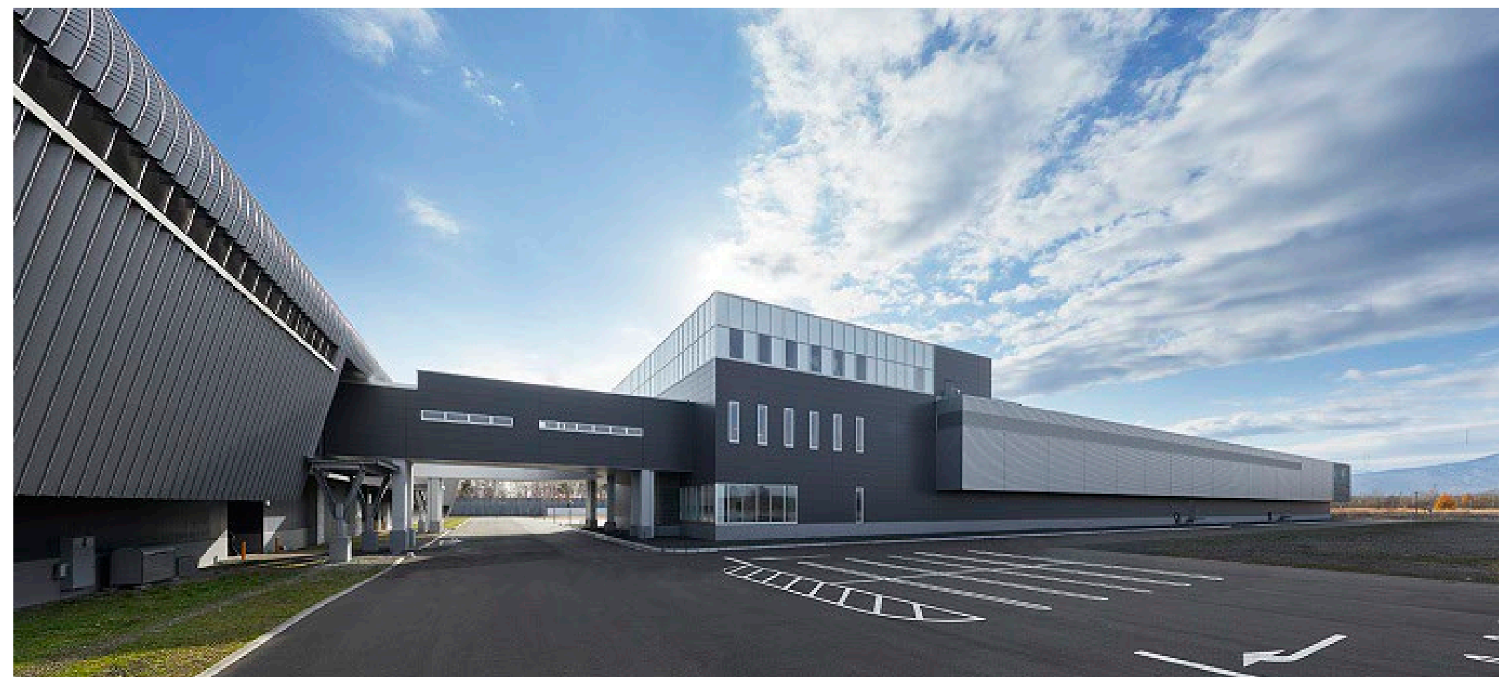
▲石狩データセンター外観（正面：3号棟、左：1・2号棟）
