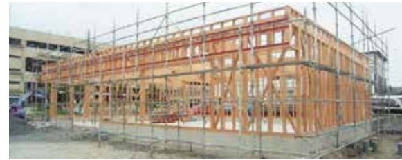
工事中のミニストップ店舗
