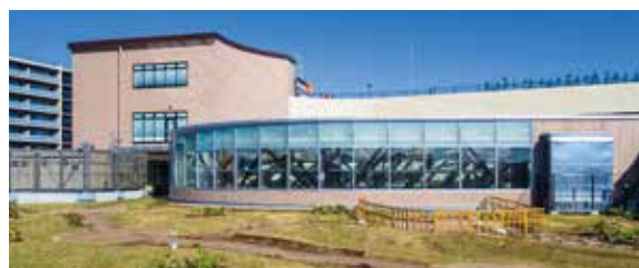
ビオトープ 一部店舗の敷地や屋上にビオトープを導入。環境学習や環境保全啓発に役立っています。
