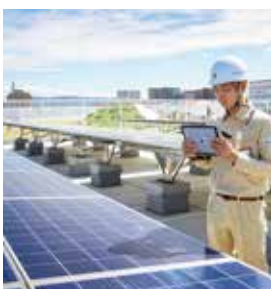
イオン藤井寺SC 設備管理者による施設巡回と最新技術を 活用した効率的な設備運用
