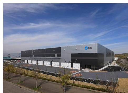
16 ロジスクエア神戸西 2020年4月竣工
