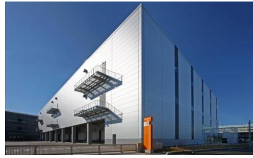
2 ロジスクエア八潮 2014年1月竣工
