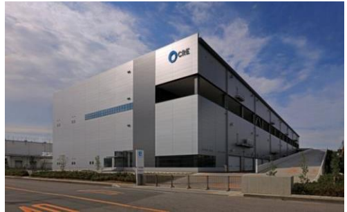
4 ロジスクエア久喜 2016年6月竣工
