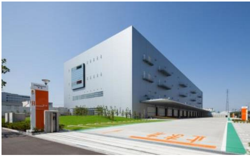
1 ロジスクエア草加 2013年6月竣工
