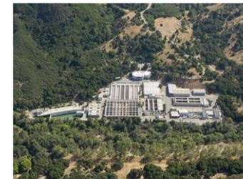
タビア下水再生施設（米国カリフォルニア州） 写真提供：ラス・ヴァージェネス水道局
