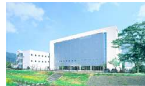
再生医療等製品の商用生産が可能な製造施設（右）
