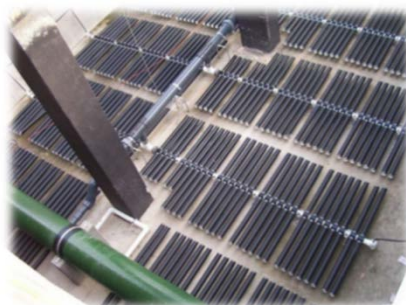
■ 超微細気泡散気装置 (FlexAir™ MiniPanel)
