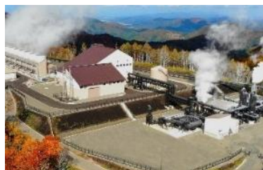
山葵沢地熱発電所 提供:湯沢地熱(株)
