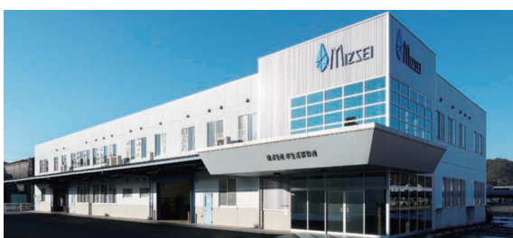
株式会社水生活製作所 本社・高富工場(岐阜県山県市)
