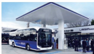
光南水素ステーション刈谷 (21年3月オープン)
