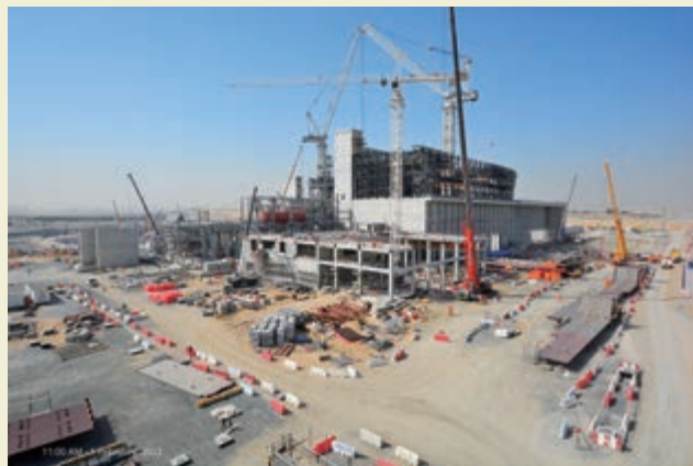
(ドバイ廃棄物処理発電プラントの建設状況)
