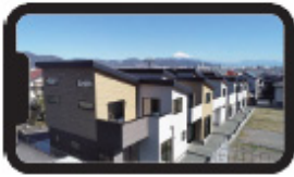
(ドローンからの空撮)
