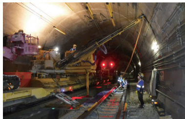
東海道新幹線大規模改修工事
