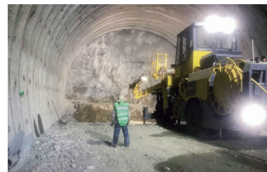
第四南巨摩トンネル東工区 (本坑の掘削)
