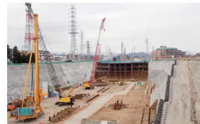
神奈川駅(仮称) (駅構造物構築に向けた掘削)
