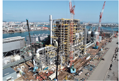
▲ 徳島津田バイオマス建設現場
