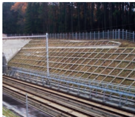
新幹線区間における盛土・切取のり面の降雨防災対策
