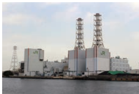
川崎発電所(火力発電所)
