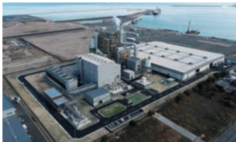
かんだ発電所
