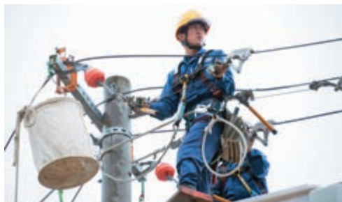
配電線工事の様子
