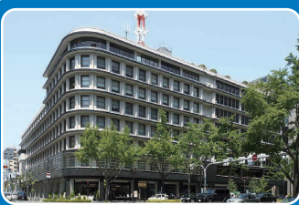
大阪ガス本社（ガスビル） 1階御堂筋側はりそな銀行です
