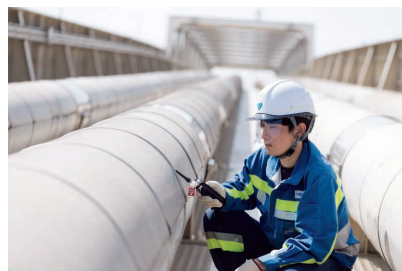
橋梁管の安全点検の様子
