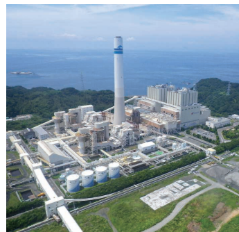
松島火力発電所 (100万kW・長崎県)
