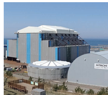
大間原子力発電所の建設状況
