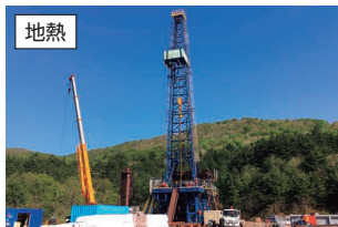
リプレース工事中の鬼首地熱発電所（宮城県）
