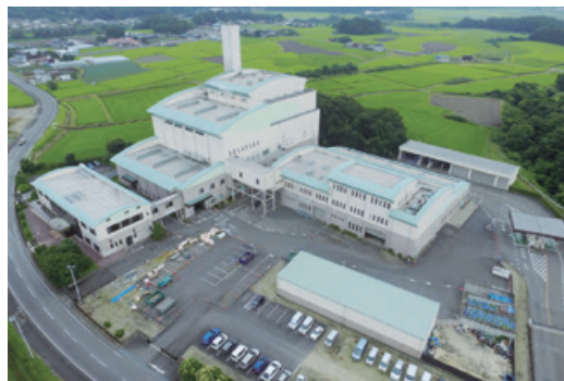
広域クリーンセンター大田原（栃木県）
