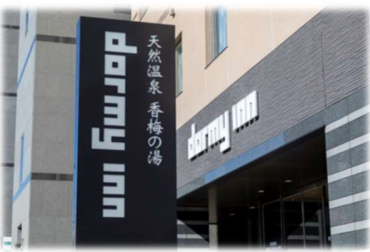
ドーミーイン水戸 (264室)
