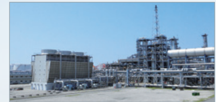
SAF製造プラント建設予定地 (コスモ石油堺製油所構内)
