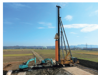
地盤改良工事 [SDM-Fit VI工法] (小野田ケミコ株式会社)
