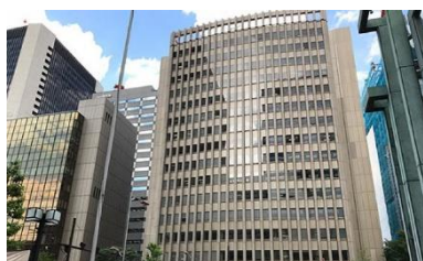
新橋カンファレンスセンター：2,813坪
