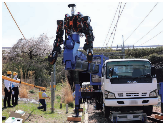
多機能鉄道重機
