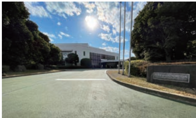
CO 2 を固定化した合成炭酸カルシウム（炭酸塩）を用いたアスファルト試験舗装
