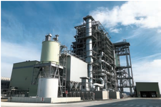
バイオマス発電プラント
