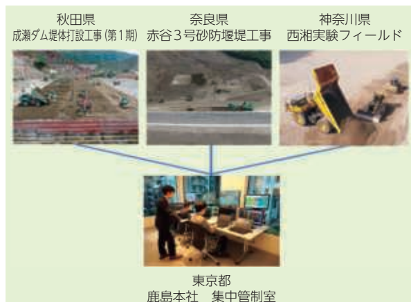
遠隔集中管制システム
