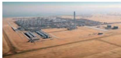
設備完成予想図 (提供：QatarEnergy)
