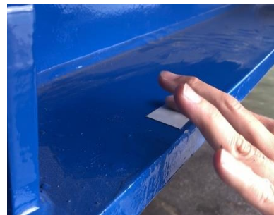
メタモルシート#1を貼付け
