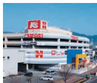
長野商業施設
