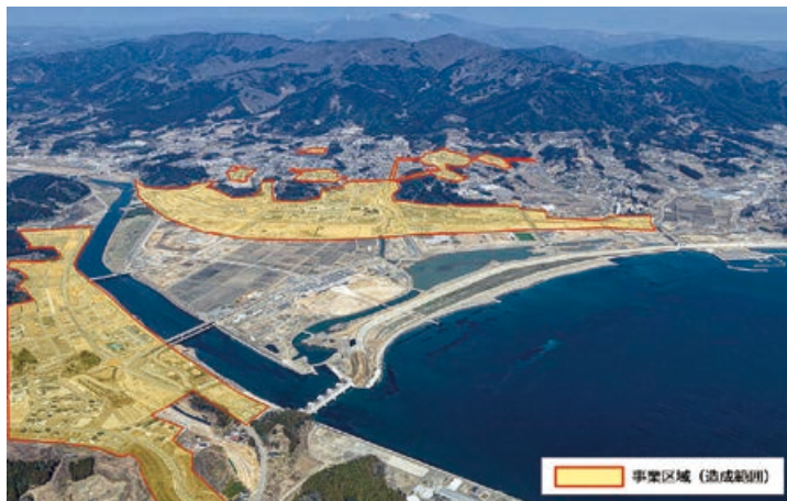
全体面積298haの宅地整備を震災後10年の節目(2021年)に完成させた
