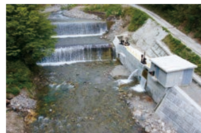
小水力発電施設「相ノ又谷水力発電所」
