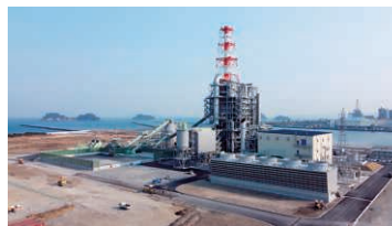
王子グリーンエナジー徳島 ／富岡エコエネルギー発電所(徳島県)
