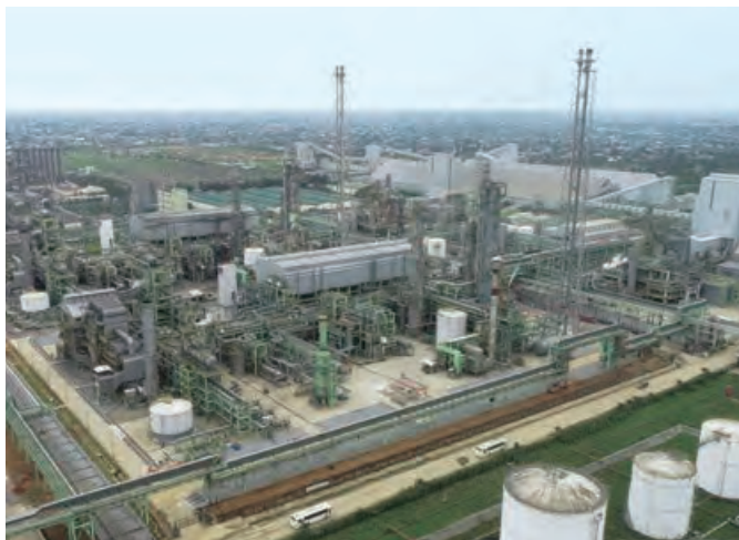
肥料プラント全景
