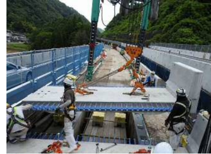
中国自動車道 大谷橋床版取替状況
