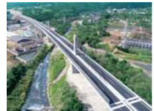
新名神高速道路路環野第二高架橋他3橋 (PC上部工) 工事
