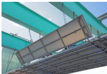
SPIDERパネル パネル式吊り棚足場
