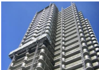
リフトクライマー 大規模修繕工事向け 移動昇降式足場
