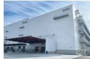
石岡センター第2生薬QC棟
